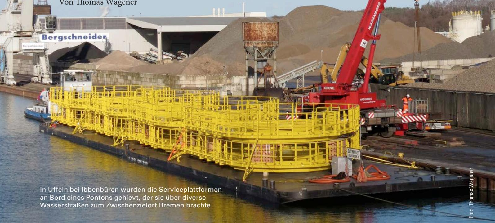
In Uffeln bei Ibbenbüren wurden die Serviceplattformen an Bord eines Pontons gehievt, der sie über diverse Wasserstraßen zum Zwischenzielort Bremen brachte
